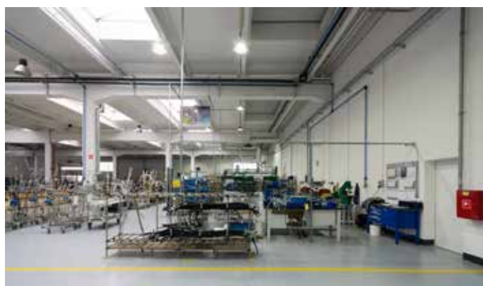
Realizacja: oprawa ATENA LED
