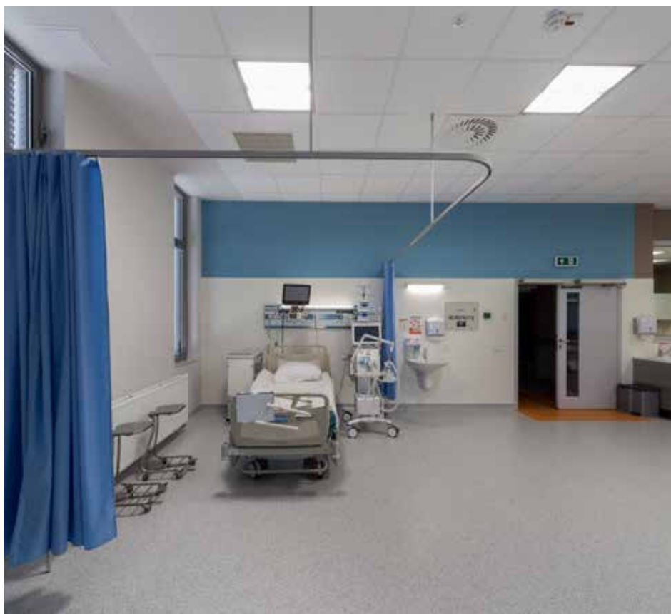
Zastosowane oprawy: Agat Clean T5, X-Wall K9 T5
