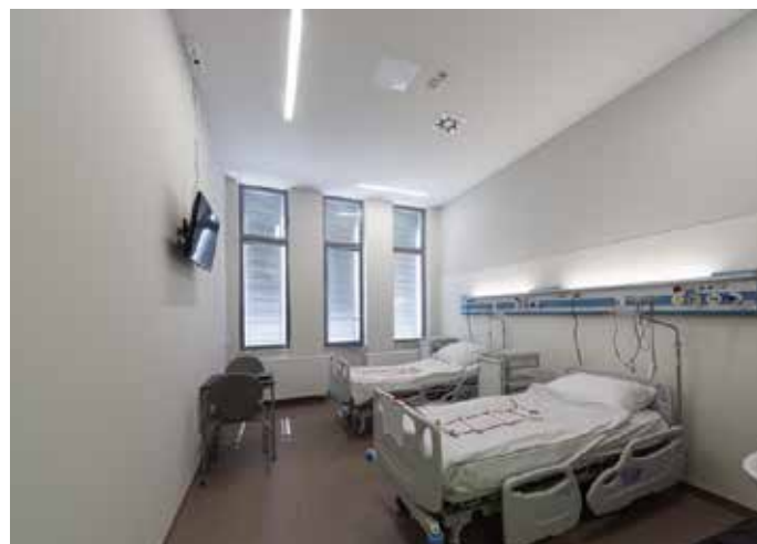
Zastosowane oprawy: X-Line G/K T5
