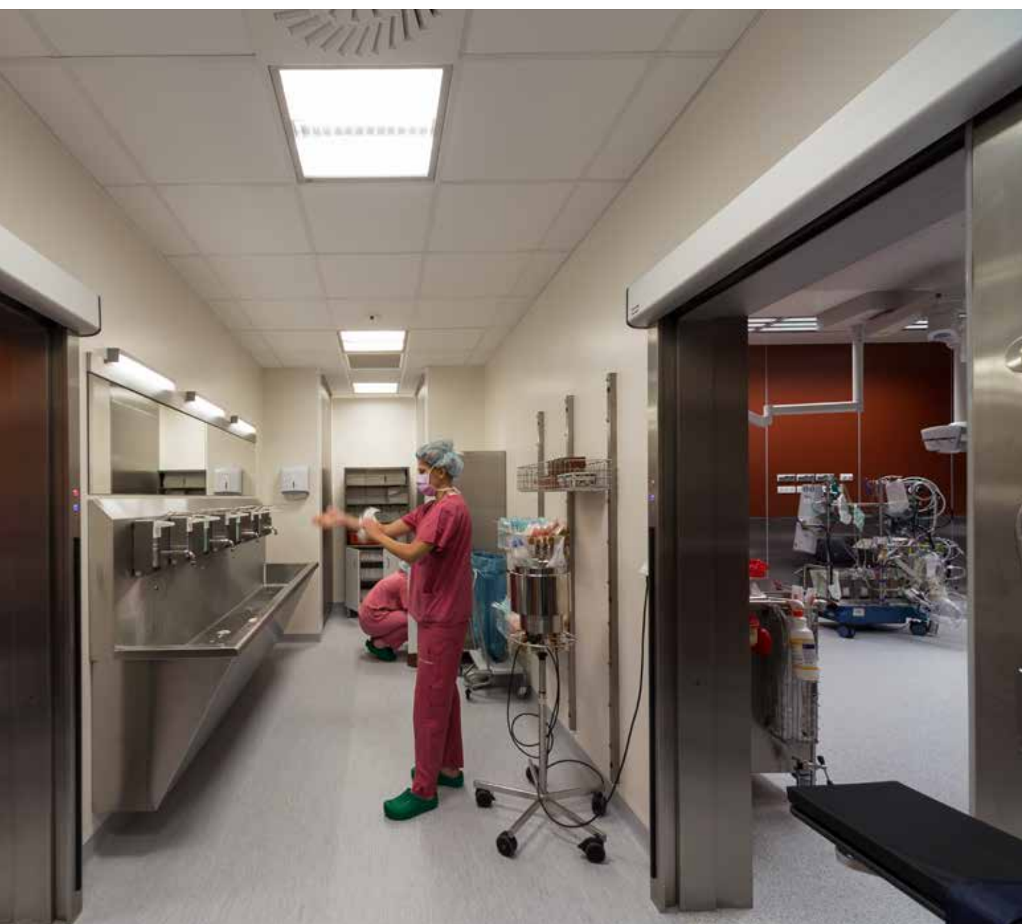
Zastosowane oprawy: Agat Clean POS TC-L, X-Wall K9 T5, Agat Clean T5
